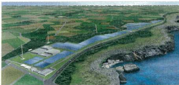
<宮古島メガソーラー実証研究設備>
