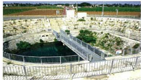
<宮古島市地下ダム資料館>
